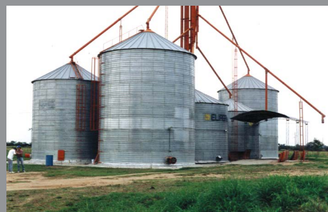
Silos de Almacenaje Calafate, Argentina
