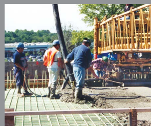
Concreto vertido en sitio
