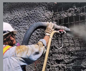
Concreto lanzado
