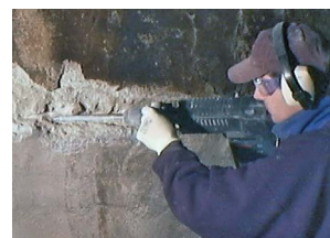
Rehabilitación Patch'n Plug & Megamix
