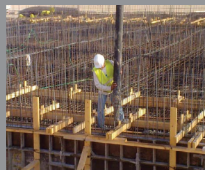
Concreto vertido en sitio
