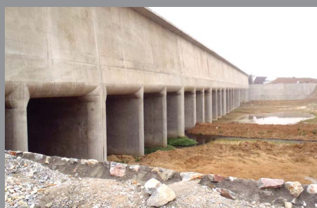
Proyecto de Transferencia de Agua Sur-Norte, China
