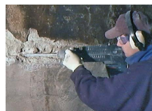
Rehabilitación Patch'n Plug & Megamix
