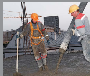
Concreto vertido en sitio
