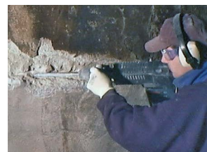
Rehabilitación Patch'n Plug & Megamix
