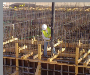
Concreto vertido en sitio
