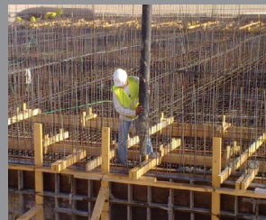
Concreto vertido en sitio
