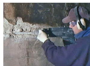
Rehabilitación Patch'n Plug & Megamix
