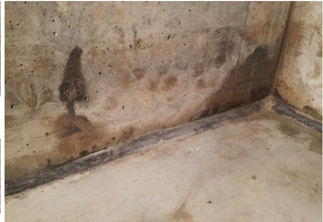
Ejemplos de estructuras bajo el nivel del suelo que presentan filtraciones y necesitan reparación
