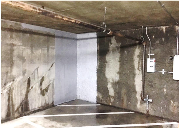
Ejemplos de estructuras bajo el nivel del suelo que presentan filtraciones y necesitan reparación
