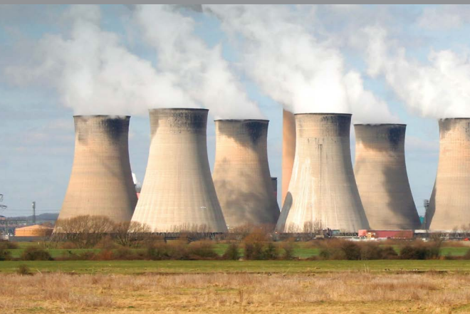
Estación de Energía Cottam, Reino Unido
