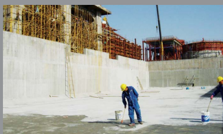
Almacenaje de Carbón en Planta Termoeléctrica, China
