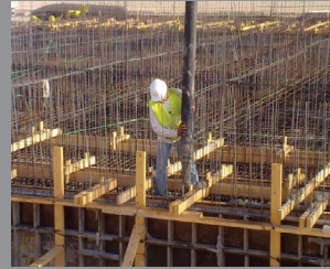
Concreto vertido en sitio
