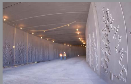
Túnel Bremerton, EUA
