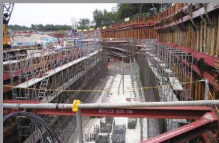
Túnel Synchroton, Japón
