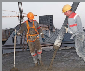
Concreto vertido en sitio
