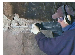
Rehabilitación Patch'n Plug & Megamix
