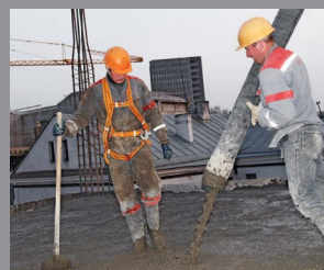
Concreto vertido en sitio
