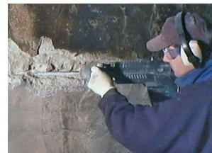
Rehabilitación Patch'n Plug & Megamix
