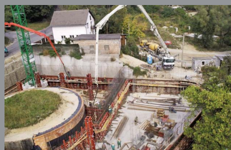
Bratislava, Reservorio de agua Koliva
