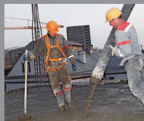
Concreto vertido en sitio
