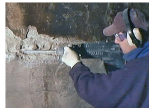
Rehabilitación Patch'n Plug & Megamix
