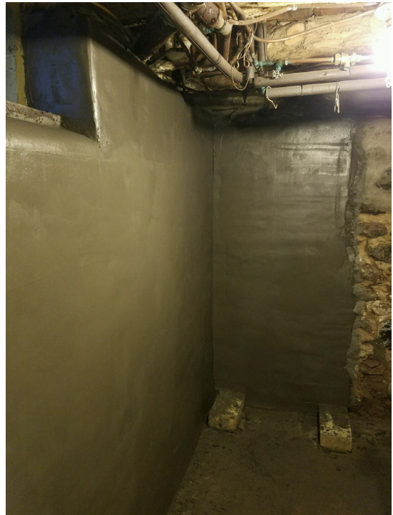
Ejemplo de Xypex Megamix II sobreconcentrado instalado en un muro de piedra.
